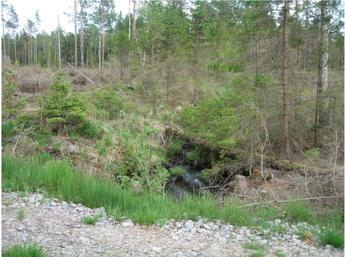
Figur 41 Befintlig väg korsar dike 17
