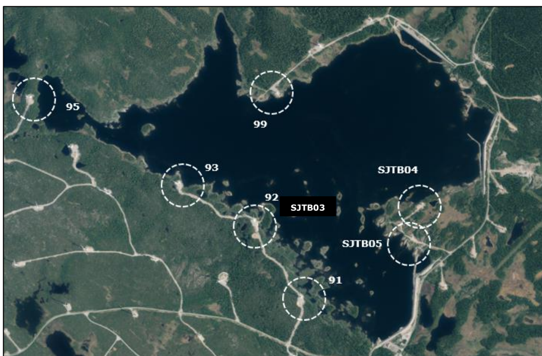
Figur 36. Översikt över vindkraftverk placerade runt Blaiksjön.
