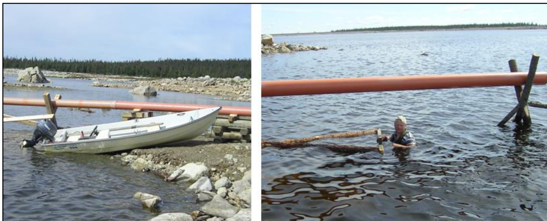
Figur 15 Deponering av anrikningssand ovan vattenytan genomförd av ScanMining september 2006 - oktober 2007. Bilder från september 2006 när Blaiksjön ligger avsänkt på nivå ca +620 m. Foto: Simon Edvardsson, Xylem.
