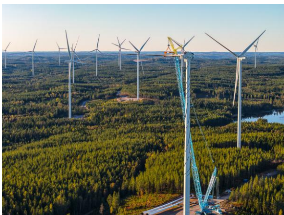
Installation av blad på det sista vindkraftverket i vindkraftparken. Foto: Bengt Ljunggren, Grafica/Bengans Reklamtryck AB
