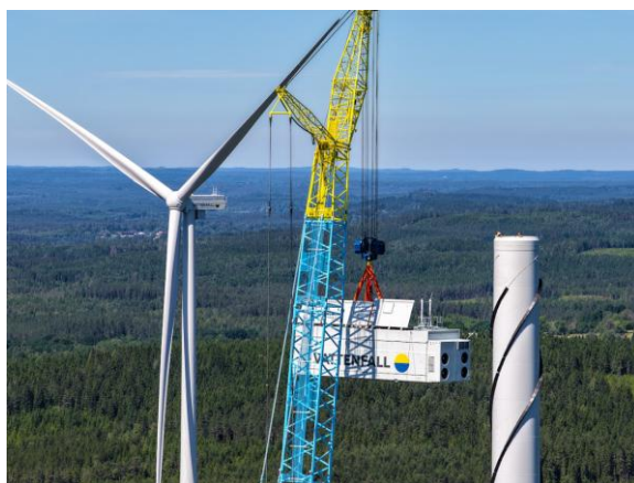
Installation av maskinhus med huvudkranen. Foto: Bengt Ljunggren, Grafica/Bengans Reklamtryck AB
