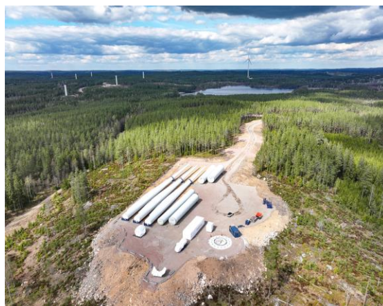
Alla delar till ett vindkraftverk har kommit på plats vid en kranplan. Fotot tydliggör behovet av yta vid en kranplan inför byggnation. I bakgrunden ses det första resta verket i vindkraftpark Bruzaholm. Foto: Bengt Ljunggren, Grafica/Bengans Reklamtryck AB
