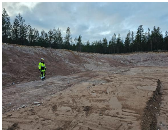
Bilden visar pågående terrassering vid ytan för batterienergilagret. Foto: Vattenfall
