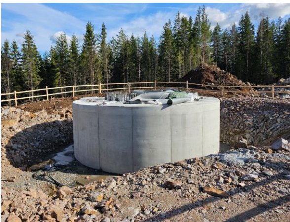
Bilden visar ett färdiggjutet fundament. Foto: Vattenfall
