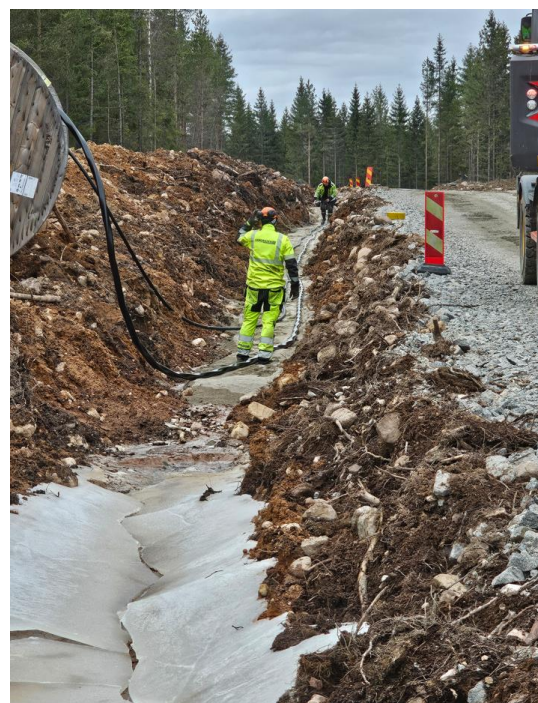
Arbetet med kabeldragningen är nu igång. Foto: Vattenfall
