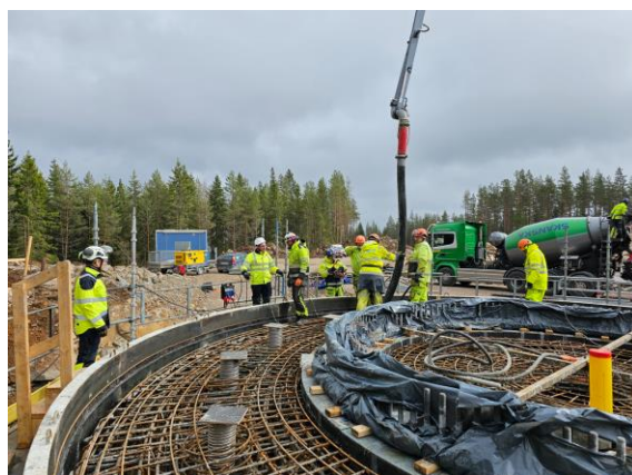
Bilden visar en pågående gjutning av ett fundament. Foto: Vattenfall
