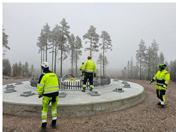
Arbete med injekteringsbruk vid ett fundament. Foto: Vattenfall
