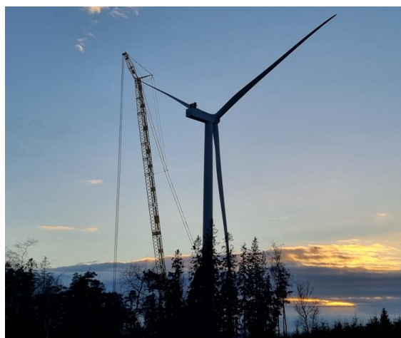
Byggnation av vindkraftverk vid Vattenfalls vindkraftpark Grönhult. Foto: Vattenfall
