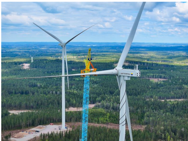
Installation av blad med huvudkranen som är 168 m hög. Foto: Bengt Ljunggren, Grafica/Bengans Reklamtryck AB
