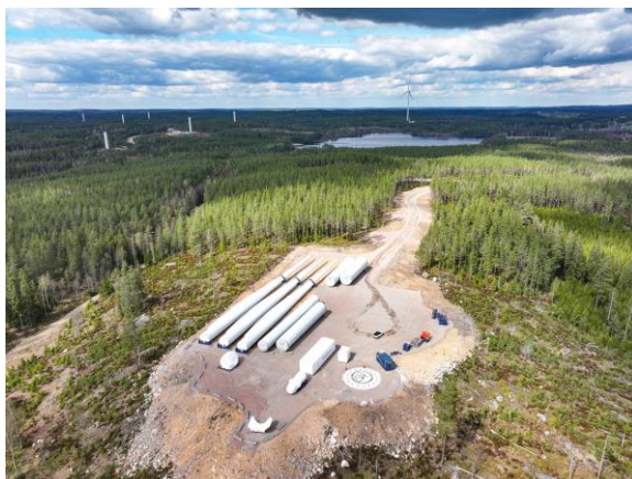
Alla delar till ett vindkraftverk har kommit på plats vid en kranplan. Fotot tydliggör behovet av yta vid en kranplan inför byggnation. I bakgrunden ses det första resta verket i vindkraftpark Bruzaholm. Foto: Bengt Ljunggren, Grafica/Bengans Reklamtryck AB
