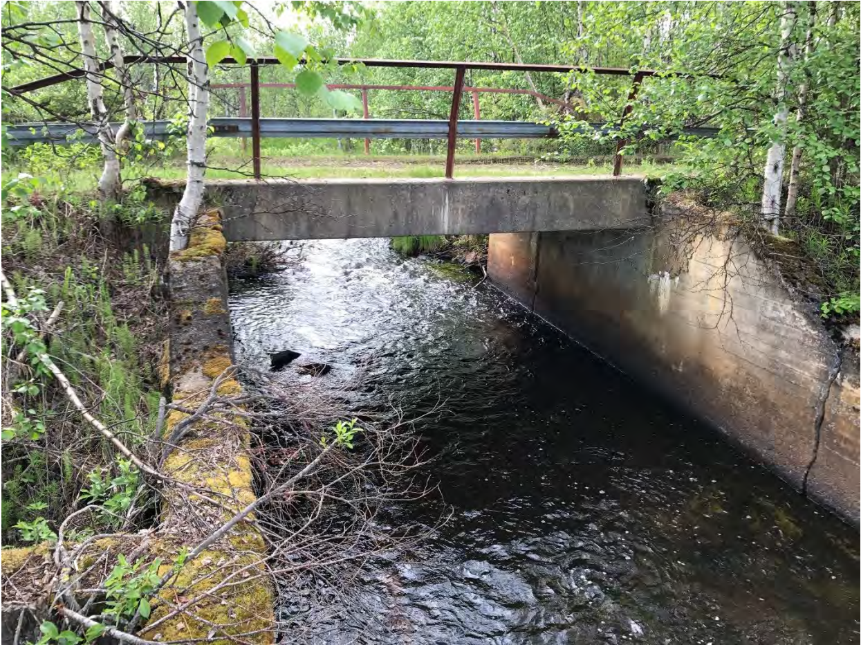
Figur 24. Käymäjoki vid bro på befintlig väg.
