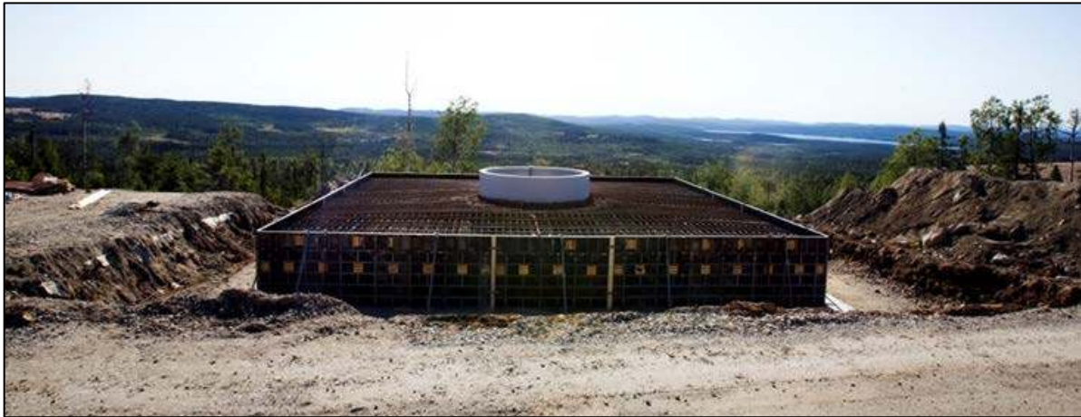
Figur 53. Bild på uppförande av gravitationsfundament. Foto: Vattenfall.
