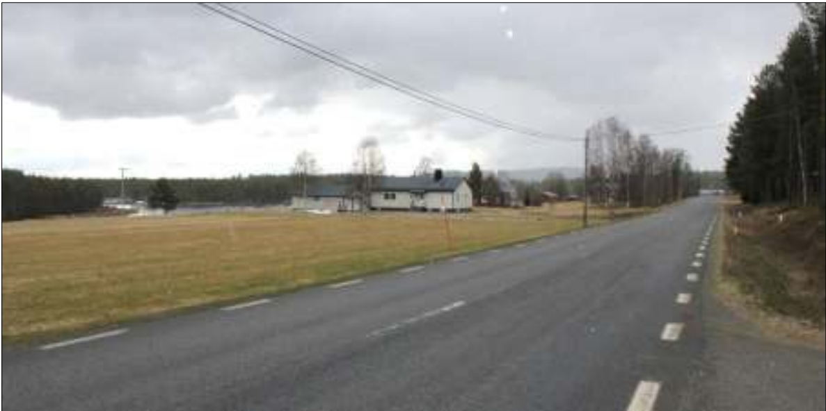
Figur 14. Väg E45 i sydlig riktning genom byn Sandsele ca 4 km från närmaste ansökansområde (Sandberget), se punkt 2 Figur 12. Fotot är taget längs E45 mot söder Foto: Petra Berggrund.
