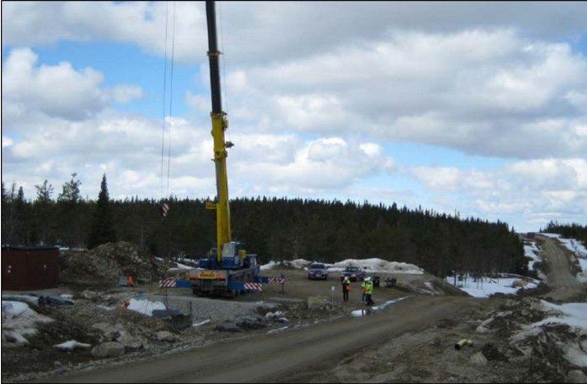
Figur 61. Exempel på montageplats och väg av Vattenfalls verk på Juktan.
