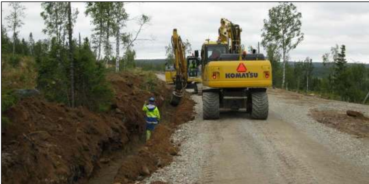
Figur 59. Grävning av kabeldike.
