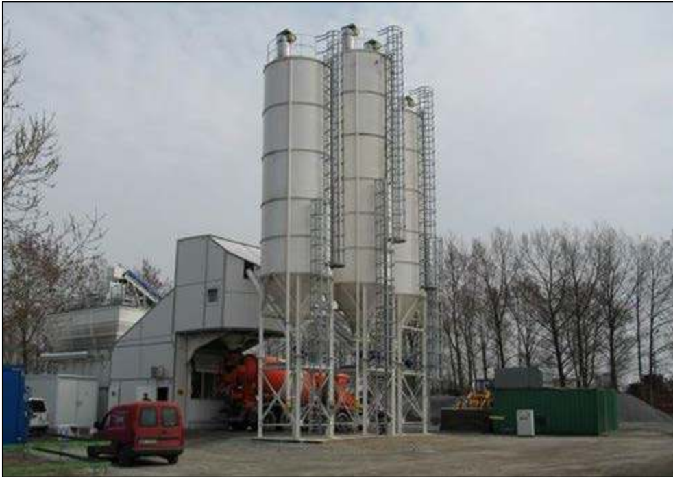
Figur 72. Temporär betongstation. Foto: Vattenfall.
