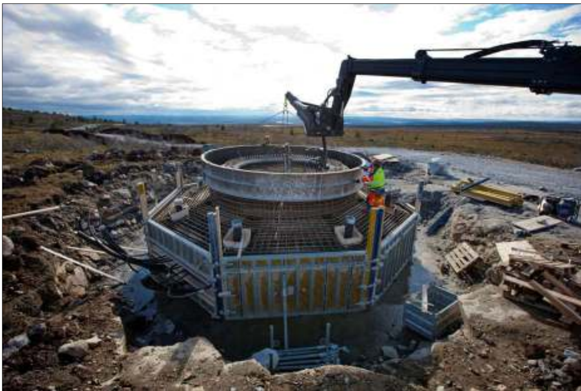
Figur 55. Bild på uppförande av bergsförankrat fundament. Foto Patrik Degerman.
