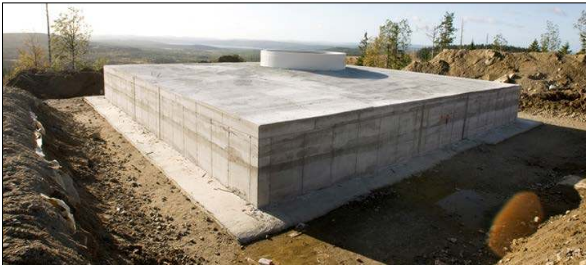
Figur 54. Bild på uppförande av gravitationsfundament. Foto: Vattenfall.
