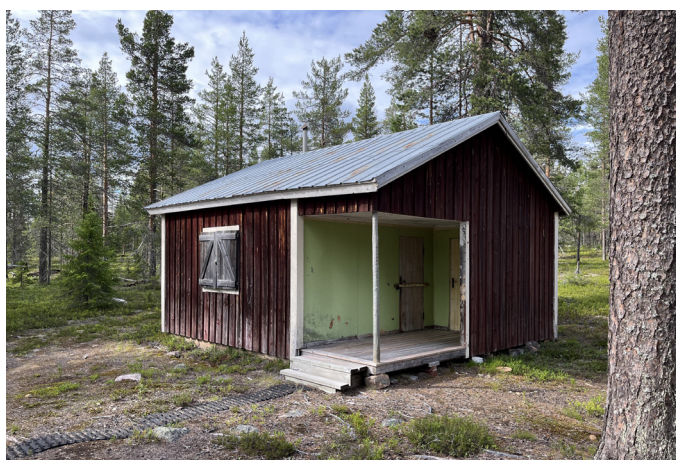
FIGUR 46 Byggnaden Ruohkoroavve, ID 515 centralt i östra delen av ansökansområdet. Foto: Ecogain.
