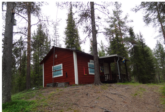
FIGUR 45 Byggnaden Lainik, ID 425 i den östra delen av ansökansområdet. Foto: Sveaskog.
