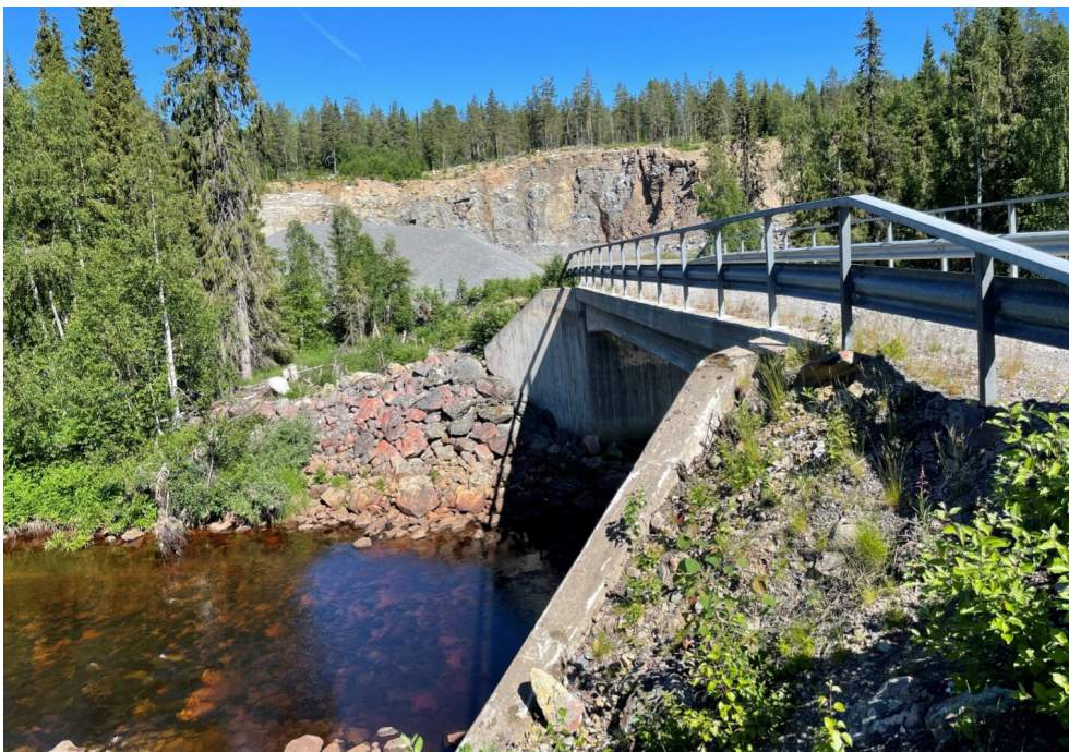
FIGUR 29 Befintlig passage med betongbro över Solälven. Foto: Barman Consulting.
