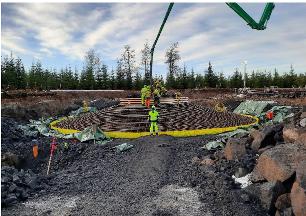
FIGUR 19 Gravitationsfundament under uppförande i Grönhult Vindkraftpark. Foto: Vattenfall
