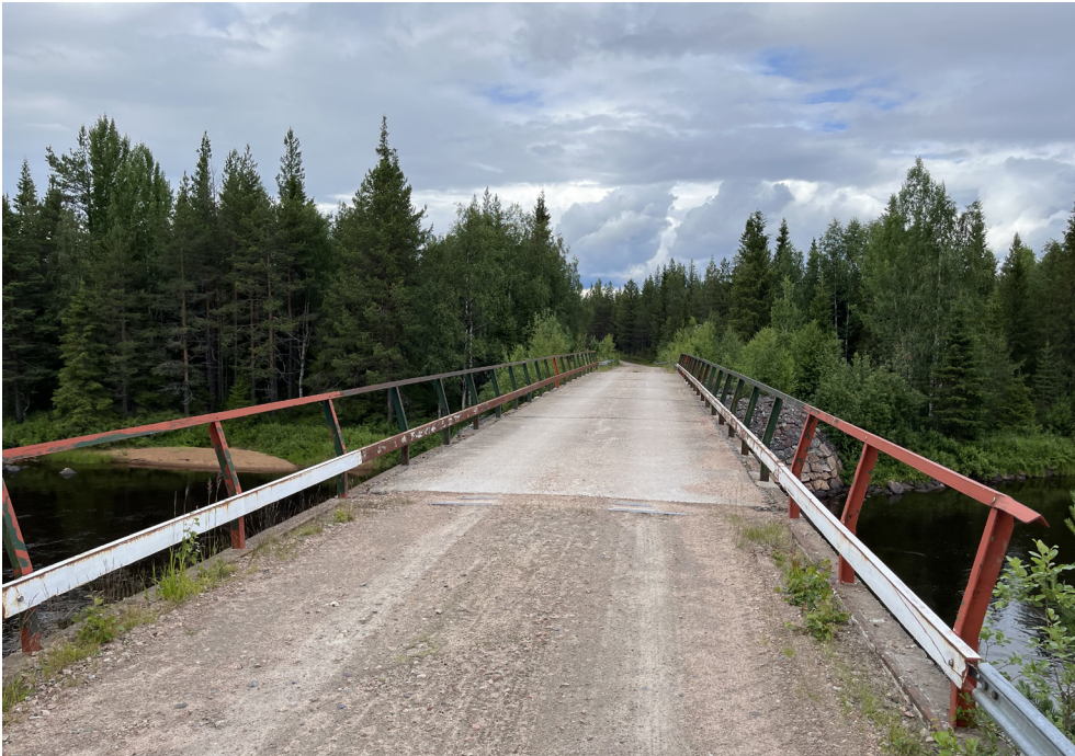
FIGUR 28 Bron vid Muorkafors har viktbegränsningar och bedöms endast komma att användas för enklare byggtrafik. Foto: Ecogain.
