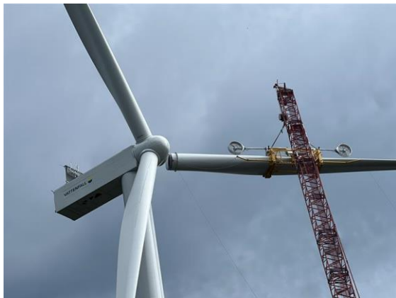
Montering av blad Foto: Vattenfall
