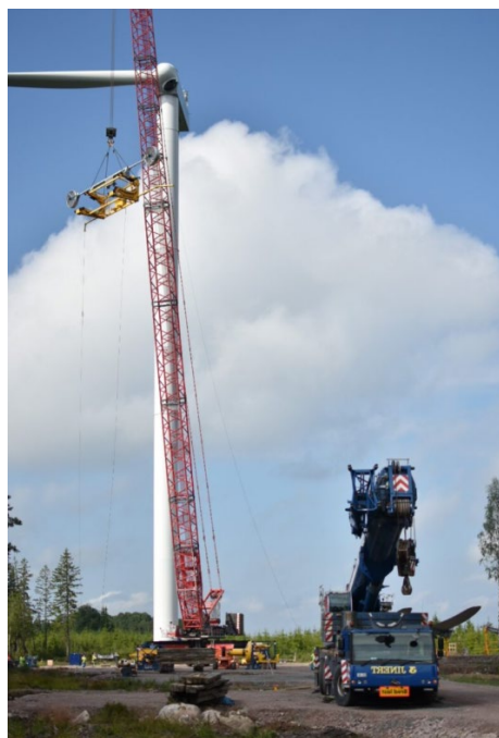
Montering av blad augusti 2025 Foto: Vattenfall
