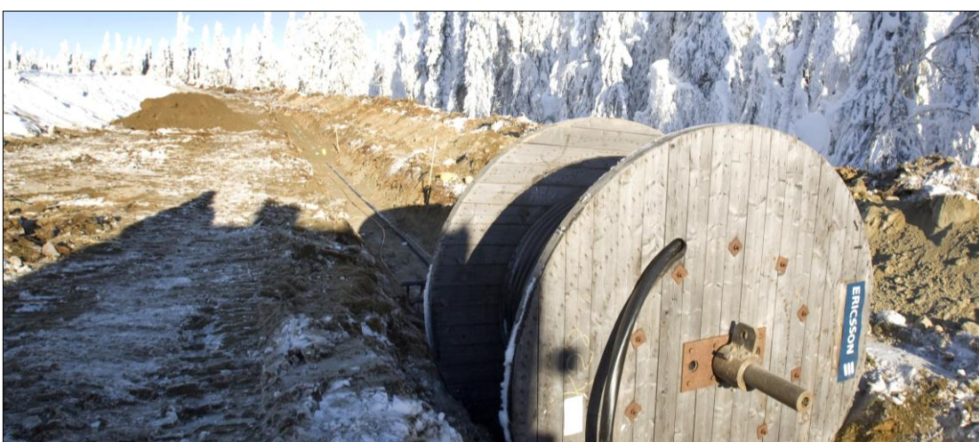
Figur 5. Foton från uppbyggnaden av vindkraftpark Stor-Rotliden. Från högst upp; ny väg inom parken, fundament och dragning av markkabel. (källa: Vattenfall Vindkraft AB).
